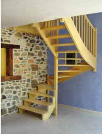
➤ **Ep-1** : Escalier 2/4 tournant en bois exotique, départ sur crémaillère à l'anglaise avec ajustage des marches sur mur en pierre, marche de départ S1, poteau de départ T1, sans contremarches, remplissage des rampes par balustres bois.
