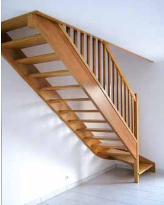
**Ep-2** ➔ Escalier 1/4 tournant en bois exotique, marche de départ S1, poteau de départ T1, sans contremarches, remplissage des rampes par balustres bois, rampe démontable.
