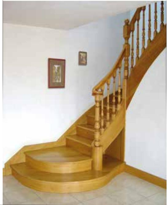
➤ **Tr-1 :** Réalisation historique respectant les procédés de fabrication de l'époque. Escalier en chêne 2/4 tournant sur limon débillardé. Poteau de départ et balustres reproduits d'après un modèle fourni.
