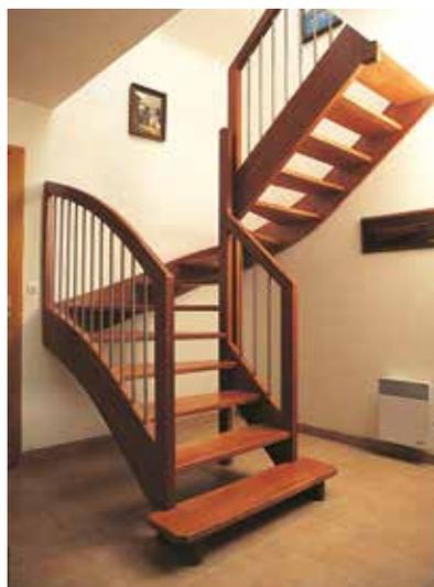
← **Ep-3** : Escalier 2/4 tournant en bois exotique rouge, marche de départ S2, poteau de départ T3, sans contremarches, remplissage des rampes par balustres inox verticaux.
