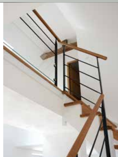
Me-5 ➤ Escalier 1/4 tournant en chêne sans contremarches, sur limon de murs et crémaillère dite "à l'anglaise".
