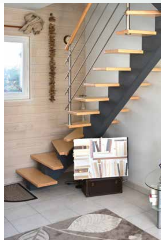
↗ → At-3 : Escalier 2/4 tournant en Frêne blanc, rampe en inox brossé PI1, main-courante MCR.
