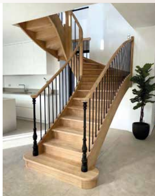
↑ St-3 Escalier 2/4 tournant en Chêne avec contremarches, marche de départ S4, poteaux de départ en fonte thermolaqué, poteaux intermédiaires débillardés T4, main-courante MC3, sur limon "à la française".
