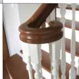
➤ ➔ Tr-3 : Escalier 1/4 tournant en Sapelli avec contremarches, marches de départ S8, départ T8, balustres tournés, main-courante MC1, sur crémaillère "à l'anglaise" avec limon de mur.
