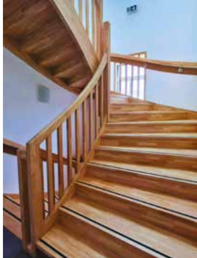
➤ Ep-1 : Escalier 1/2 tournant en Hévéa avec contremarches, poteau de départ T3, balustres AC, rampe intérieure courbe, bandes antidérapantes et main-courantes murales sur écuyers.
