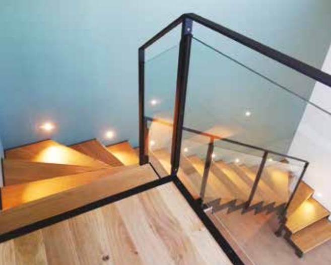
➤ Ma-1 : Escalier 2/4 tournant avec marches en Chêne sans contremarches, structure en limon "à la française" découpé dessus/dessous, vitrages en parecloes, main-courante plate en acier thermolaqué.
