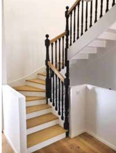
➤ Tr-1 : Escalier 2/4 tournant en Chêne avec contremarches, poteaux et balustres tournés, main-courante MC2, sur limon "à la française"
