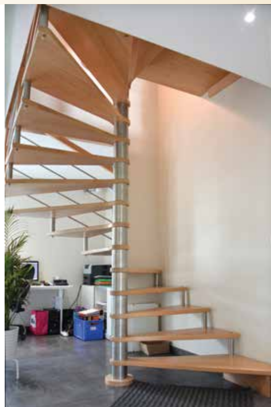
Na-3 → Escalier hélicoïdal carré en Hêtre avec entretoises de fût et extérieures en inox, poteaux T1, lisses en inox, main-courante MC2.
