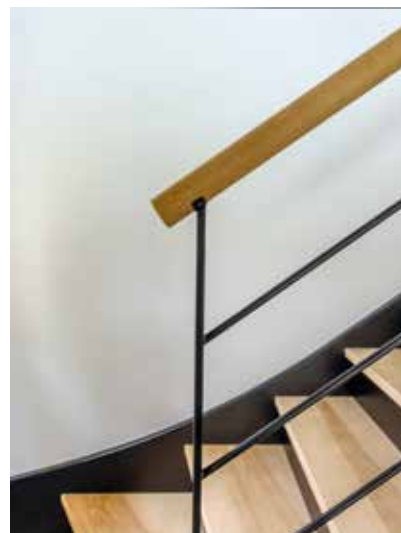
Me-2 → Détail rampes : supports MC bois
