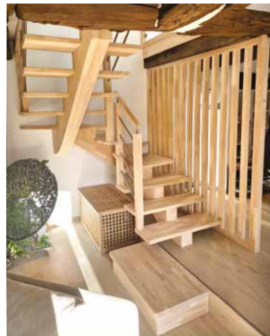
At-2 → Escalier 1/2 tournant en Hévéa, marche de départ S1, rampe modèle T6, claustra toute hauteur au départ.
