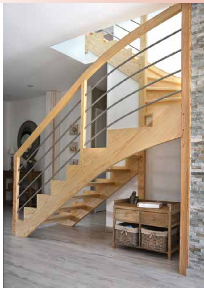
De-3 → Escalier 1/2 tournant en Frêne blanc, poteau de départ T3, lisses en inox, départ sans contremarches et arrivée avec contremarches.
