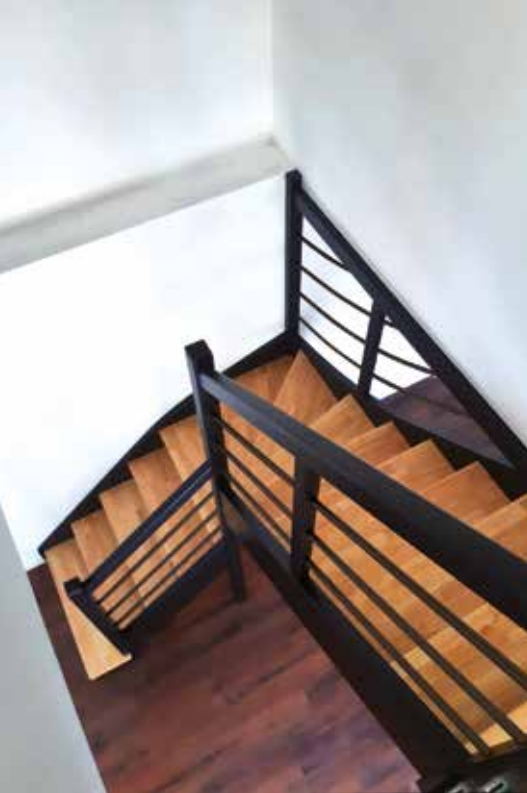
← Ho-1 : Escalier 1/4 tournant en Hévéa sans contremarches, marche de départ S1, poteaux T1, main-courantes MC2, claustra extérieur.
