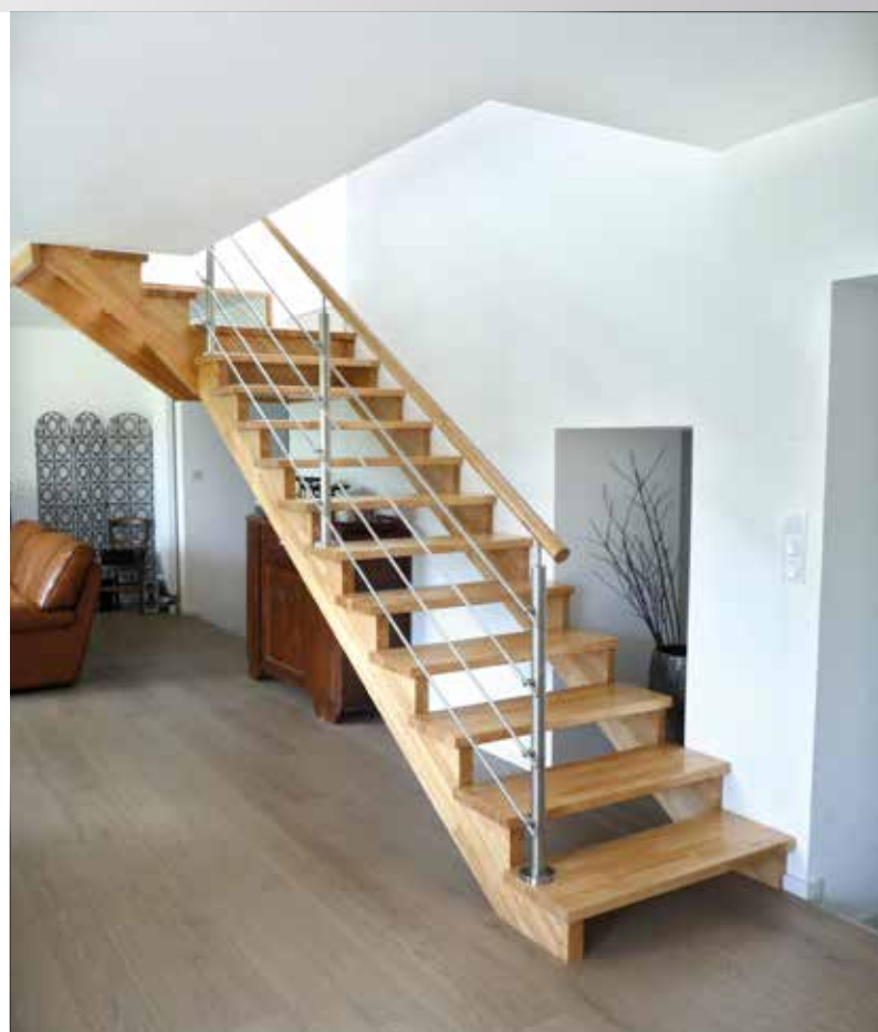
Mf-3 → Escalier 1/4 tournant avec palier en Hévée sans contremarches, sur crémaillères "à l'anglaise".
