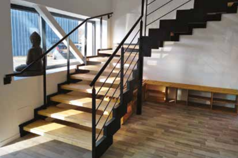
↑ De-1 Escalier 1/4 tournant en Hévéa sans contremarches, rampes PM1 et main-courante MC4 continue en acier thermolaqué.
