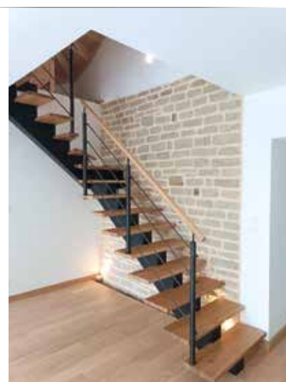
← At-4 : Escalier 1/4 tournant en Chêne, rampe modèle PI1 avec revêtement noir anthracite, main-courante MCR.
