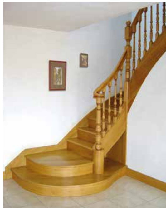
Tr-2 → Escalier 2/4 tournant en Chêne avec contremarches, premières marches en palier galbé, poteaux de départ tourné avec volute T5, balustres tournés, main-courante MC1, sur limon "à la française", rampe courbe.
