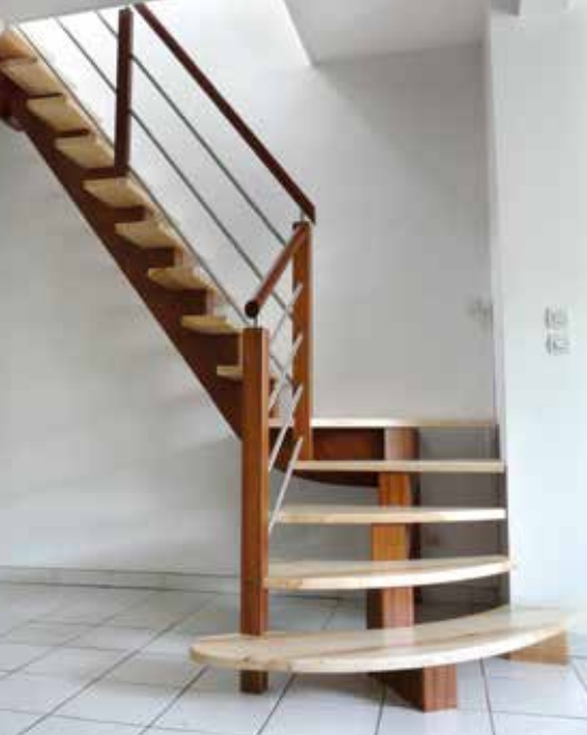
← At-1 Escalier 1/4 tournant en Sapelli et Frêne Olivier, marche de départ galbée, rampe modèle T6.
