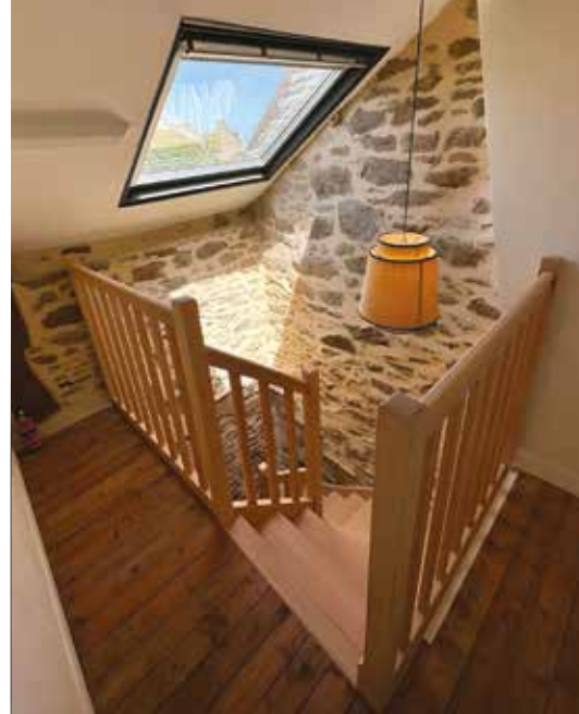
Ep-2 ➔ Escalier 2/4 tournant en Hêtre sans contremarches, poteaux T1, balustres G, main-courantes MC1, de conception traditionnelle avec crémaillère et plinthe murale massives.
