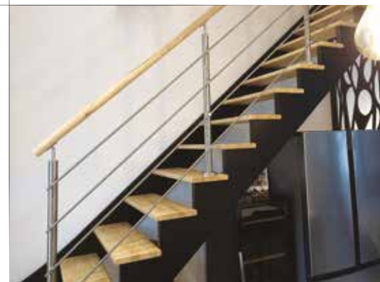
↑ Mf-2 : Escalier droit en Hévée sans contremarches, sur crémaillère "à l'anglaise" et limon de mur.
