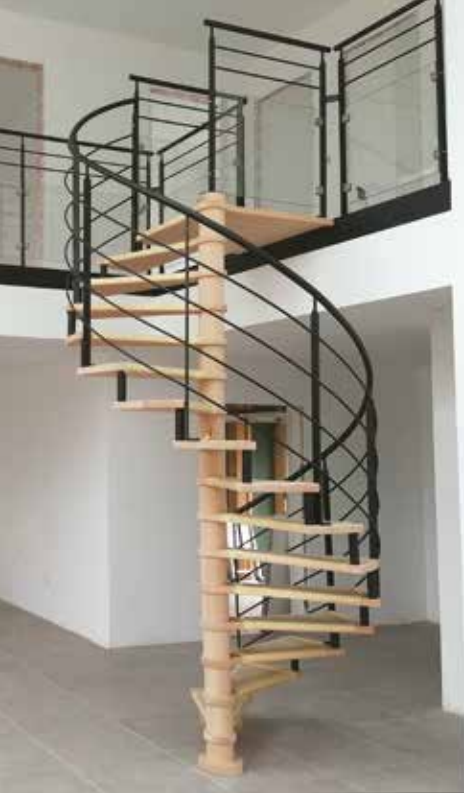
← Na-1 : Escalier hélicoïdal circulaire en Hêtre avec entretoises de fût tournées et entretoises extérieures en acier thermolaqué, rampe et main-courante débillardés en acier thermolaqué.
