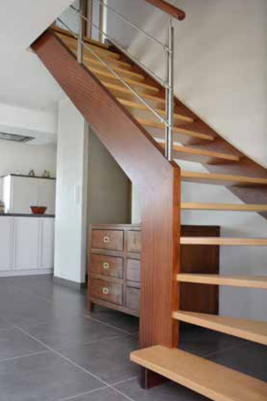
← Mf-1 : Escalier 1/4 tournant en Sapelli et Frêne blanc sans contremarches, marche de départ S1, avec retombée de limon.
