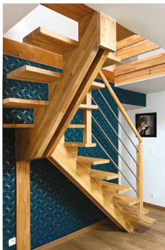
Eq-3 : Escalier 1/4 tournant en Hévéa, rampe modèle T6, structure DCC2.
